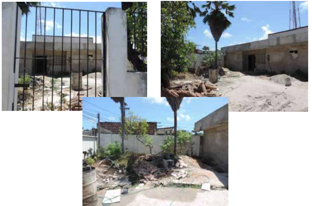
Obras no Posto de Saúde Joaquim Nabuco, no Varadouro.
